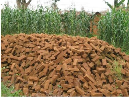
Aus diesen Steinen werden die Häuser gebaut. Eine Grube wird ausgehoben und der Lehm wird dann in Formen gestrichen. Neben jedem Bau finden sich solche Lehmgruben. Manche Steine sind lediglich von der Sonne getrocknet. Die besseren sind gebrannt. Aus diesen Steinen wird das Dekanatshaus entstehen.
